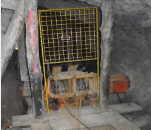
Limpieza con winches de arrastre
