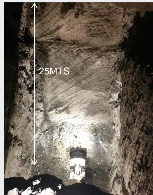
Cara expuesta en relleno cementado
